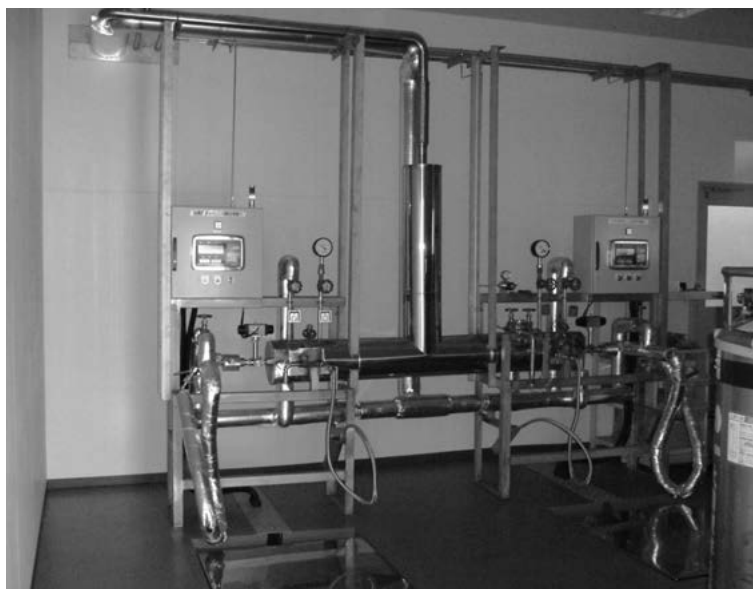
【液化酸素 (LGC) 自動充填装置 施工例】
